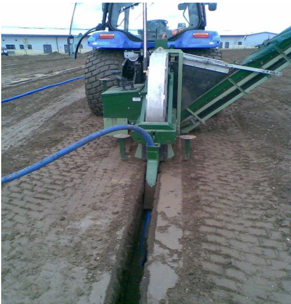
Εικ. 4-5 διάνοιξη αυλάκων αρδευτικού δικτύου
