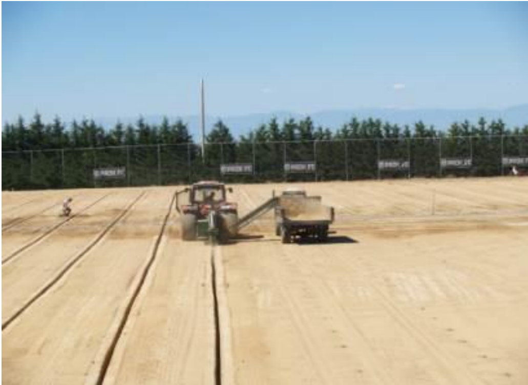
Εικ.2 Διάνοιξη αυλάκων σωλήνων αποστράγγισης
