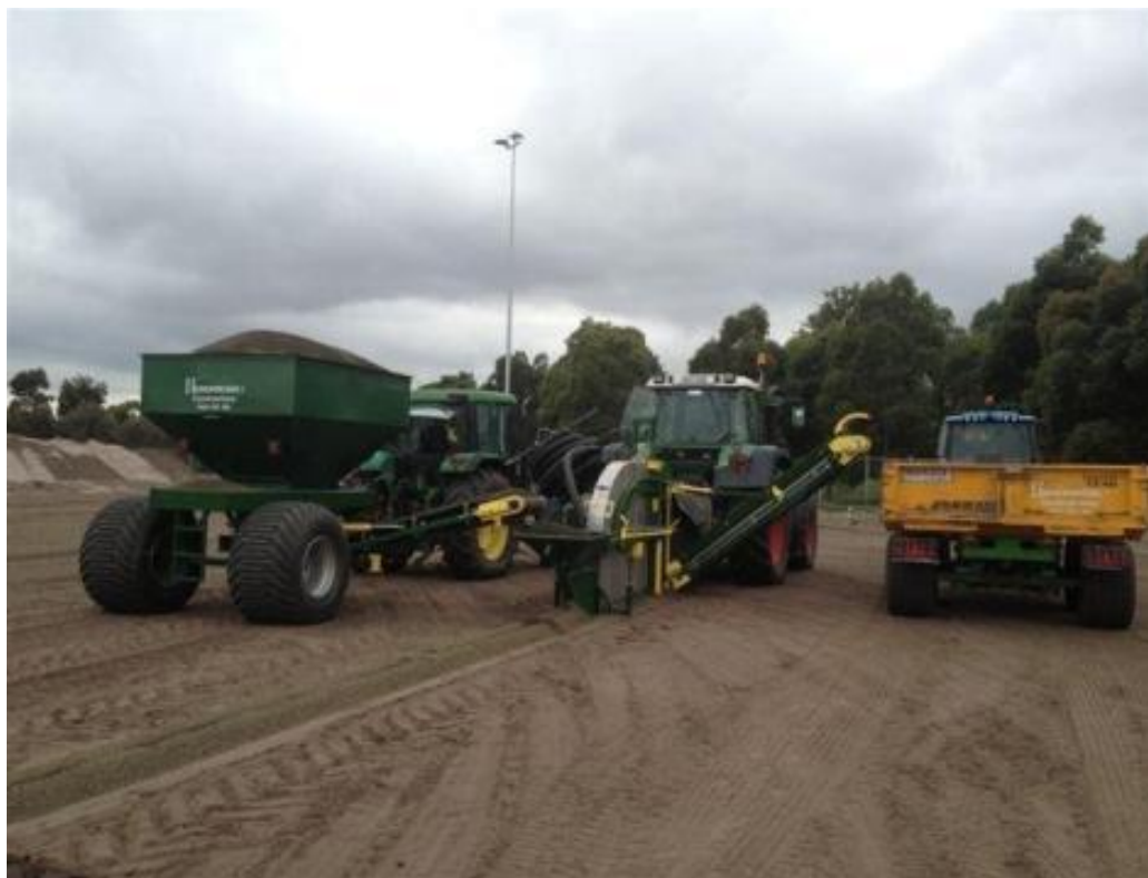
Εικ.3 Επίστρωση φυτικού υποστρώματος
